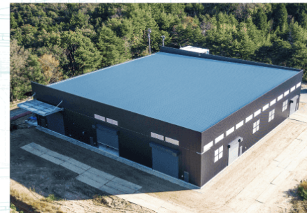
▲ 2022年12月現在 建屋完成
