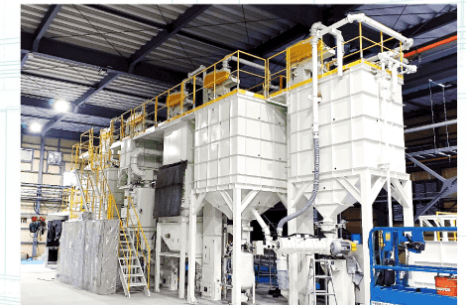
▲ 設備搬入状況の一例
