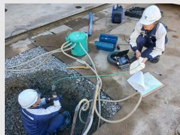
東邦ガステクニによる能登半島地震の導管復旧工事の現地支援
