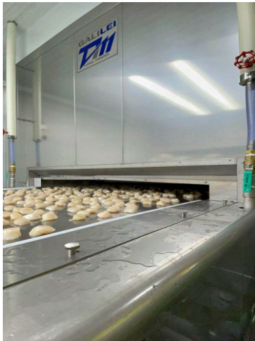
新設トンネルフリーザーは2月より稼働
